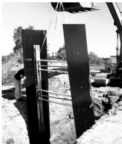
Les rails peuvent être boulonnés au Finform, etc. (Voir page 1 pour les contreplaqués de remplacement)
